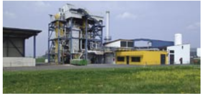
Abb. 3 (Figure 3): Biomasse-Vergasungsanlage in Güssing (Wirbelschichtvergasung) Quelle: Technische Universität Wien
