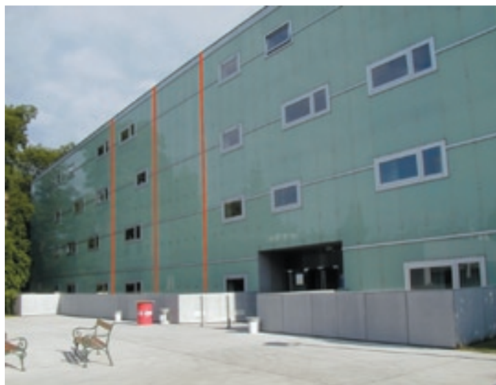
Abb. 1: Südansicht des Versuchsobjektes mit Messfeldern „Fenster“ und „Wand“
