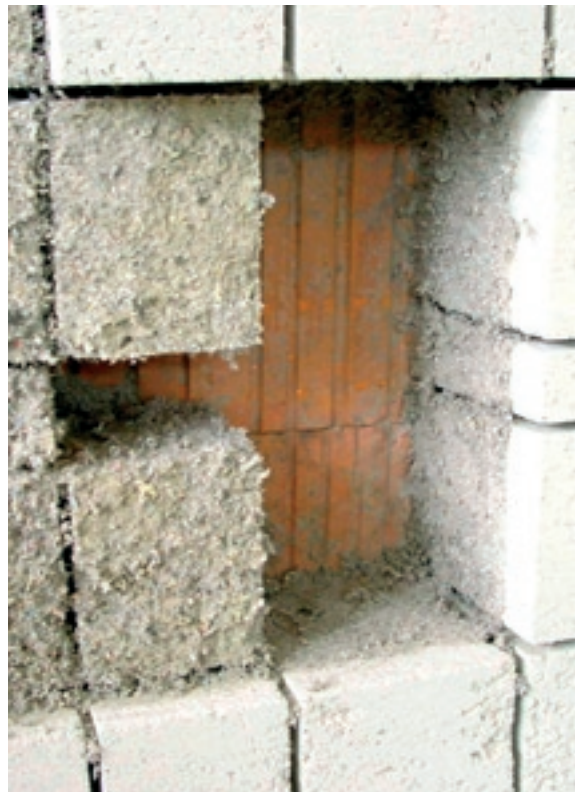
Entwicklung eines aufsprühbaren zellulosebasierten Dämmstoffes (Institut für Hoch- und Industriebau)
